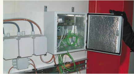
Module Bluetooth installé dans le boîtier d'une navette mobile.
